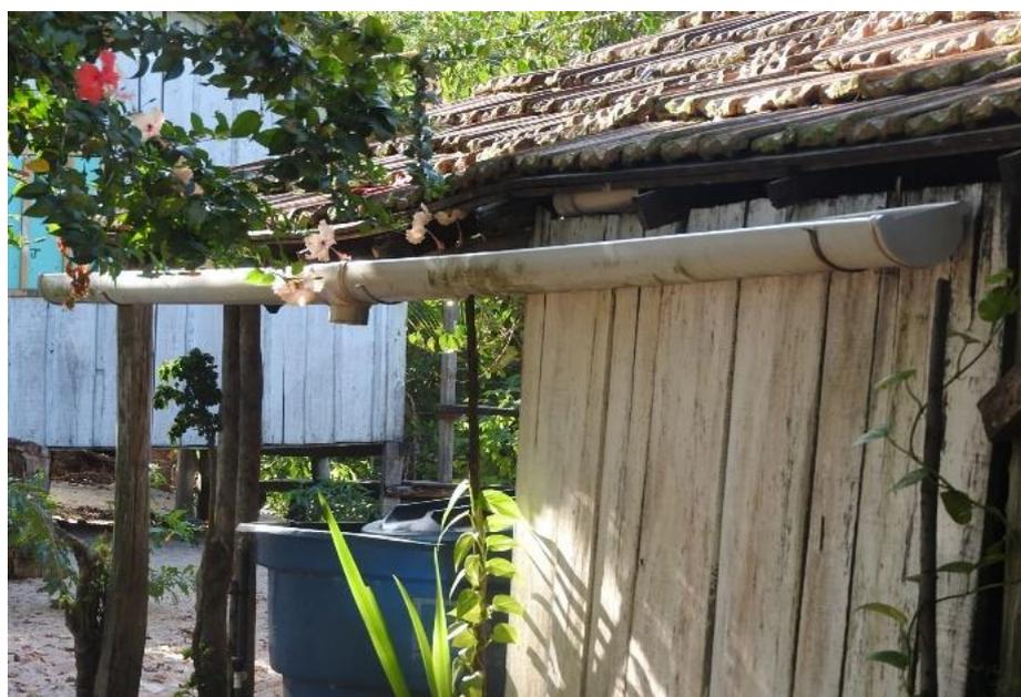
*Figura 10. Calhas de cano na beirada do telhado para parar água da chuva.*
