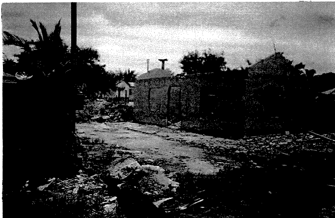
Demolições na Terra Indígena de Coroa Vermelha
