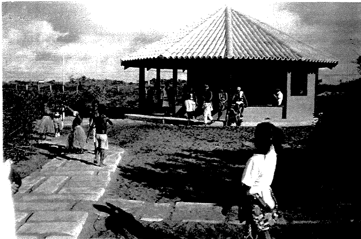
Escola indígena Pataxó de Coroa Vermelha (construção nova)
