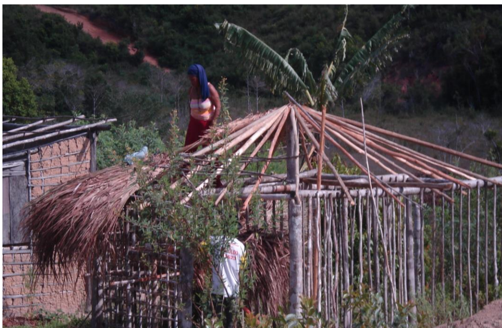
Figura 20 - Kijeme em construção – aldeia Kaí Foto: Leila 2007
