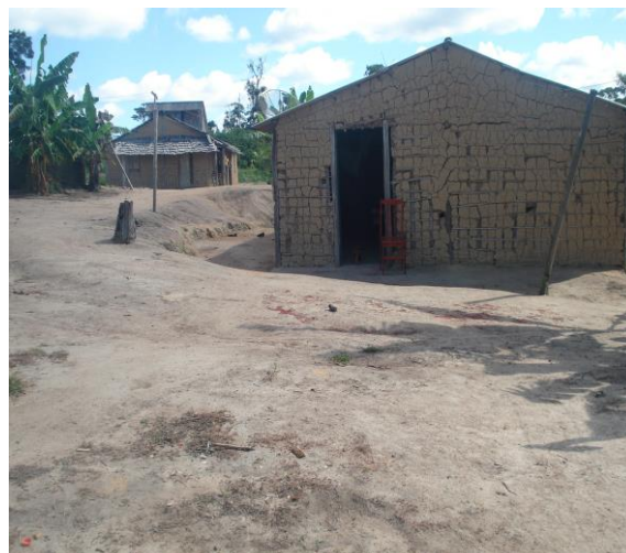
Figura 31– Casas de taipa com telha Eternit ao lado do roçado da família
