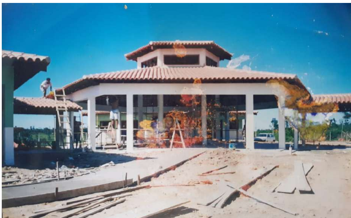
Figura 20: Escola atual em construção 2002. Fotografia acervo de Saiara.
