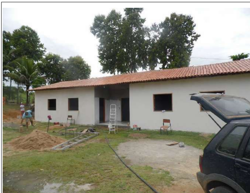
Figura 24: Comunidade trabalhando na construção das duas salas de aula anexo à escola atual. Foto de 2014 disponível no facebook da escola.
