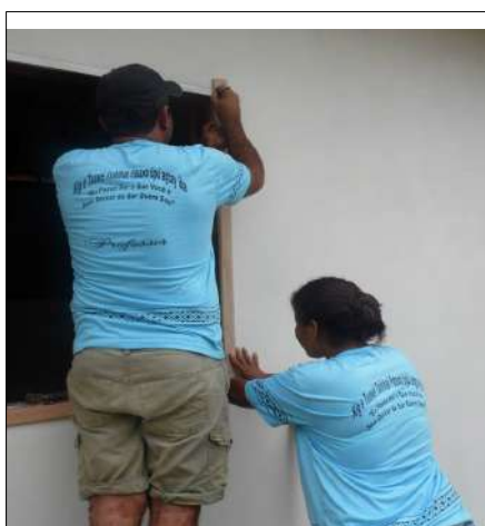
Figura 21: Comunidade trabalhando na construção das duas salas de aula, anexo à escola atual. Foto de 2014 disponível no facebook da escola
