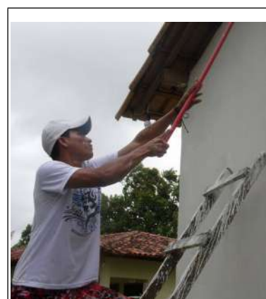
Figura 23: Comunidade trabalhando na construção das duas salas de aula anexo à escola atual. Foto de 2014 disponível no facebook da escola.
