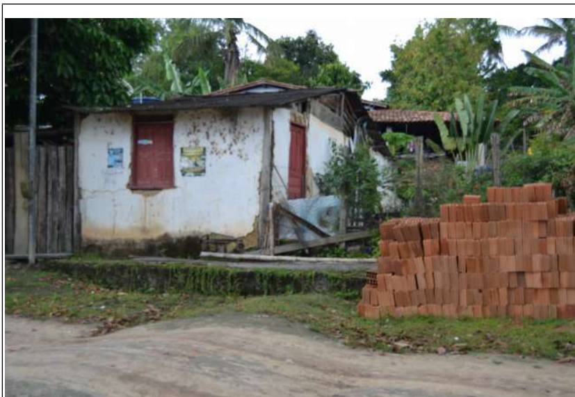
Figura 17: Vista frontal da única sala que restou da antiga escola. (Sala "A" conforme figura 14)
