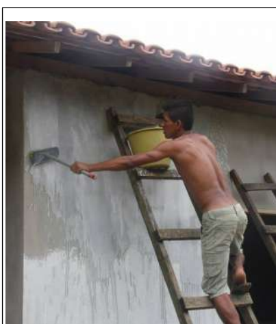
Figura 22: Comunidade trabalhando na construção das duas salas de aula, anexo à escola atual. Foto de 2014 disponível no facebook da escola
