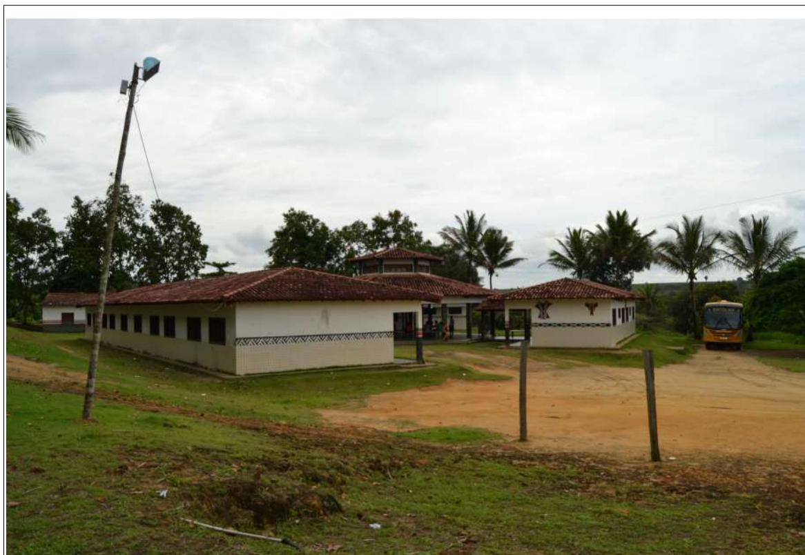
Figura 19: Escola Indígena de Boca da Mata, visão externa. Registro realizado no dia da oficina.
