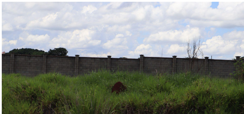
Figura 6 – Muro construído para cercar a propriedade de terra, ao lado da Perimetral Norte
