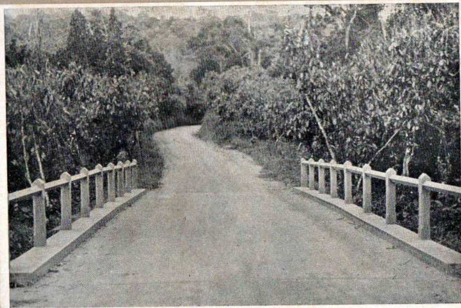
PONTE DO RIBEIRÃO DE AREIA.
