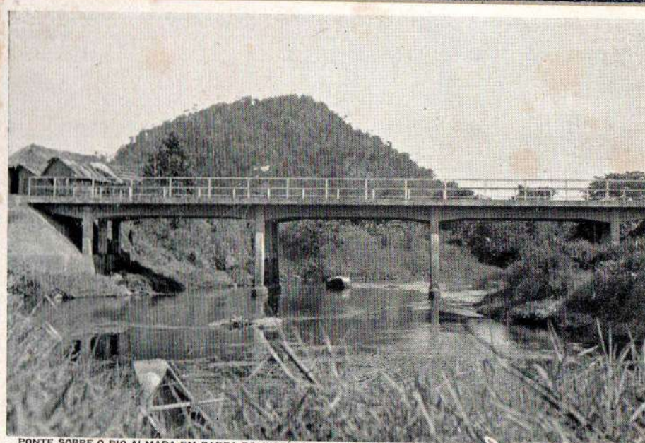
PONTE SOBRE O RIO ALMADA EM BARRA DO JUSSARA. - BRIDGE OVER THE ALMADA RIVER IN BARRA DO JUSSARA.
